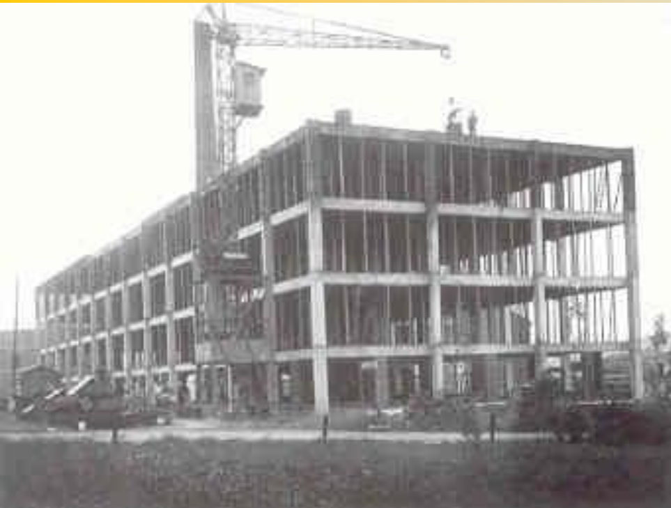
Výstavba továrního areálu
