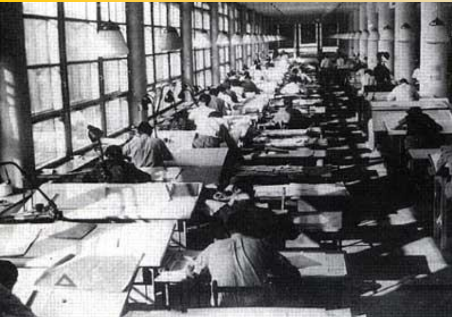
Správní budova č. 21, interiery z r. 1940
