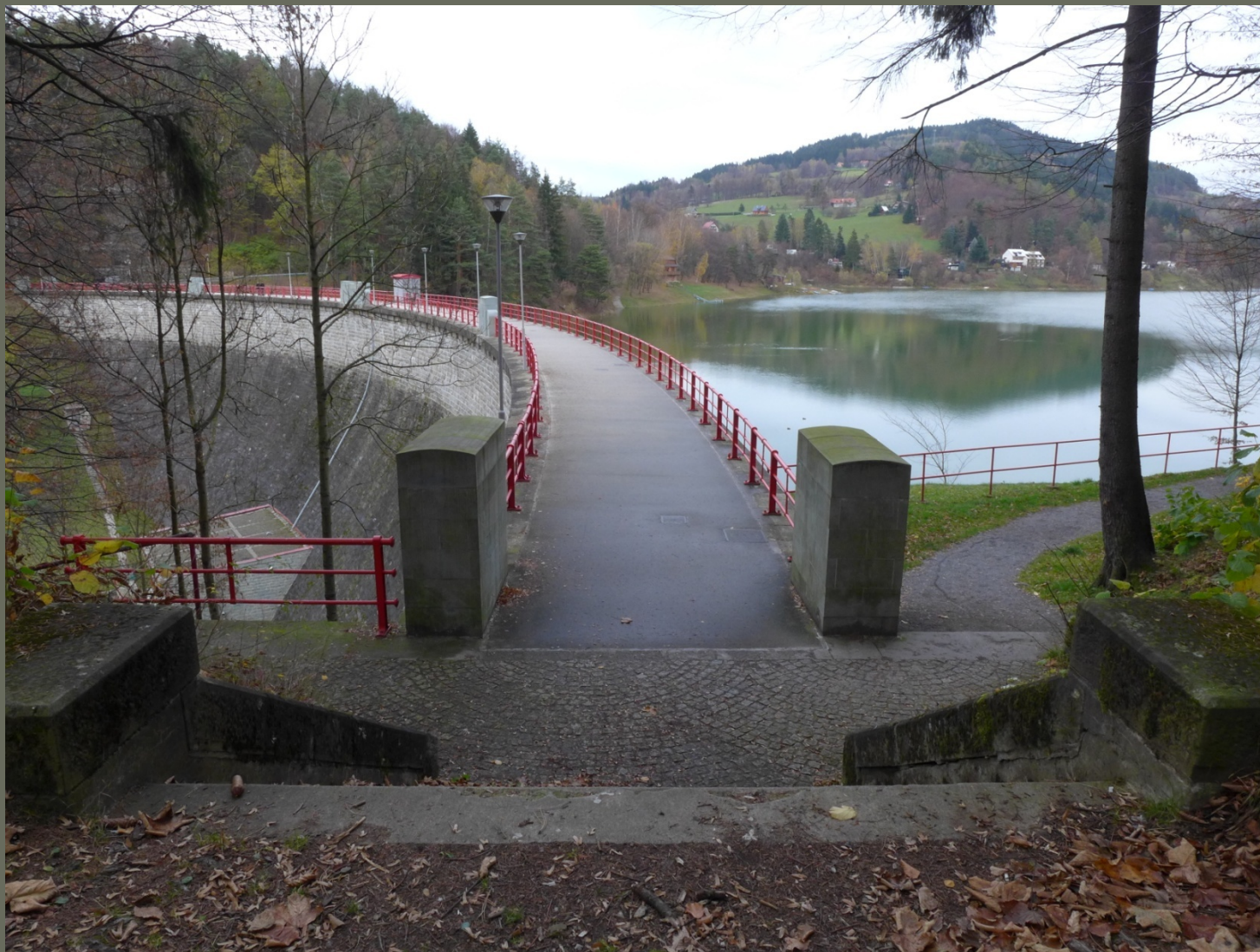
Bystřička, napájecí přehrada kanálu Odra- Dunaj, 1908 - 1910
