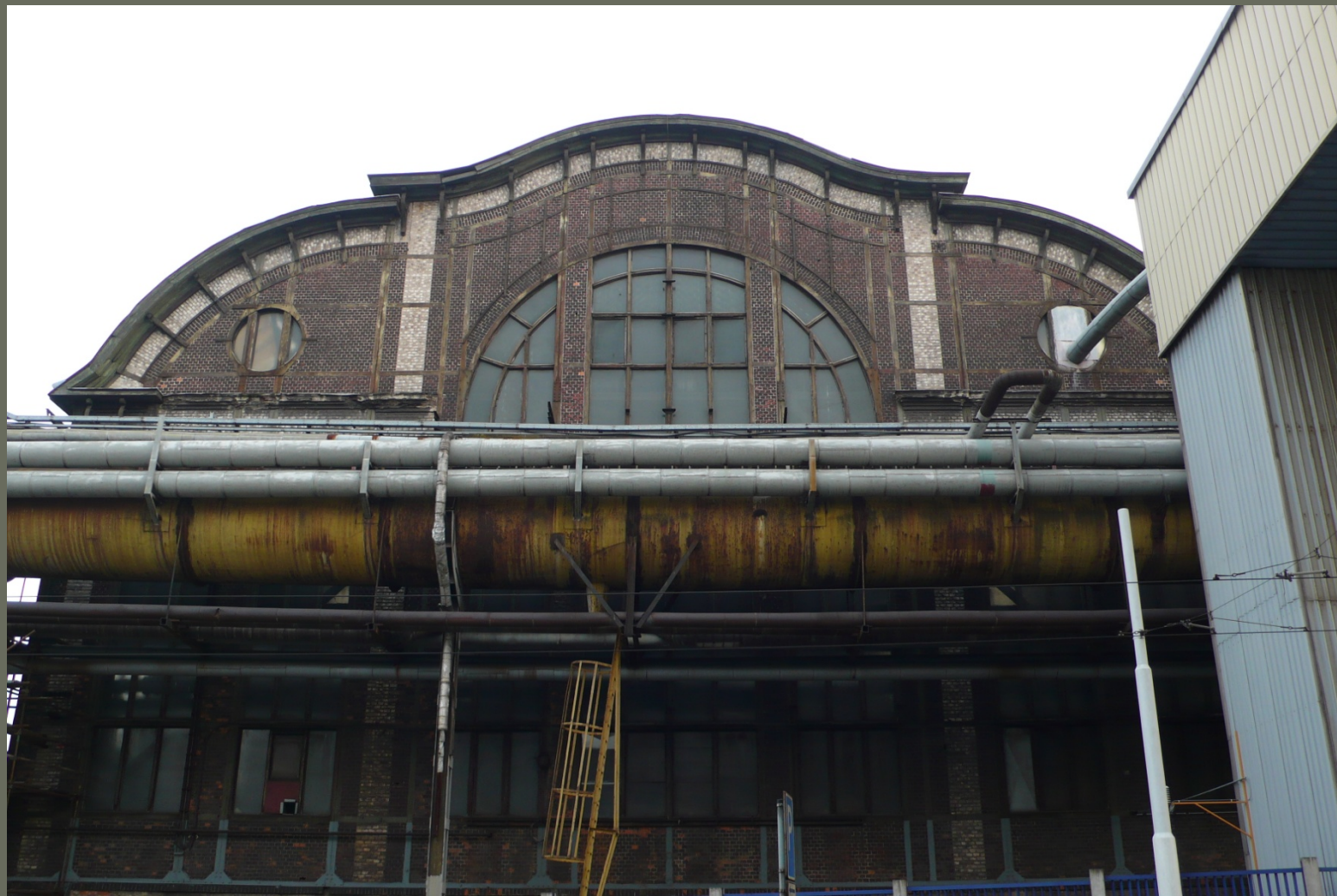
Vítkovice, elektrárna č. IV., 1911
