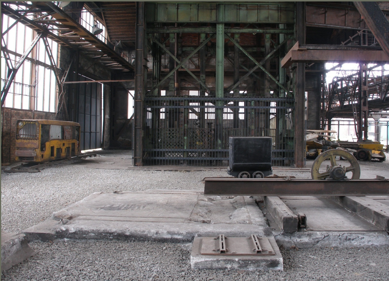
Důl Hlubina, zpřístupnění jámové budovy
