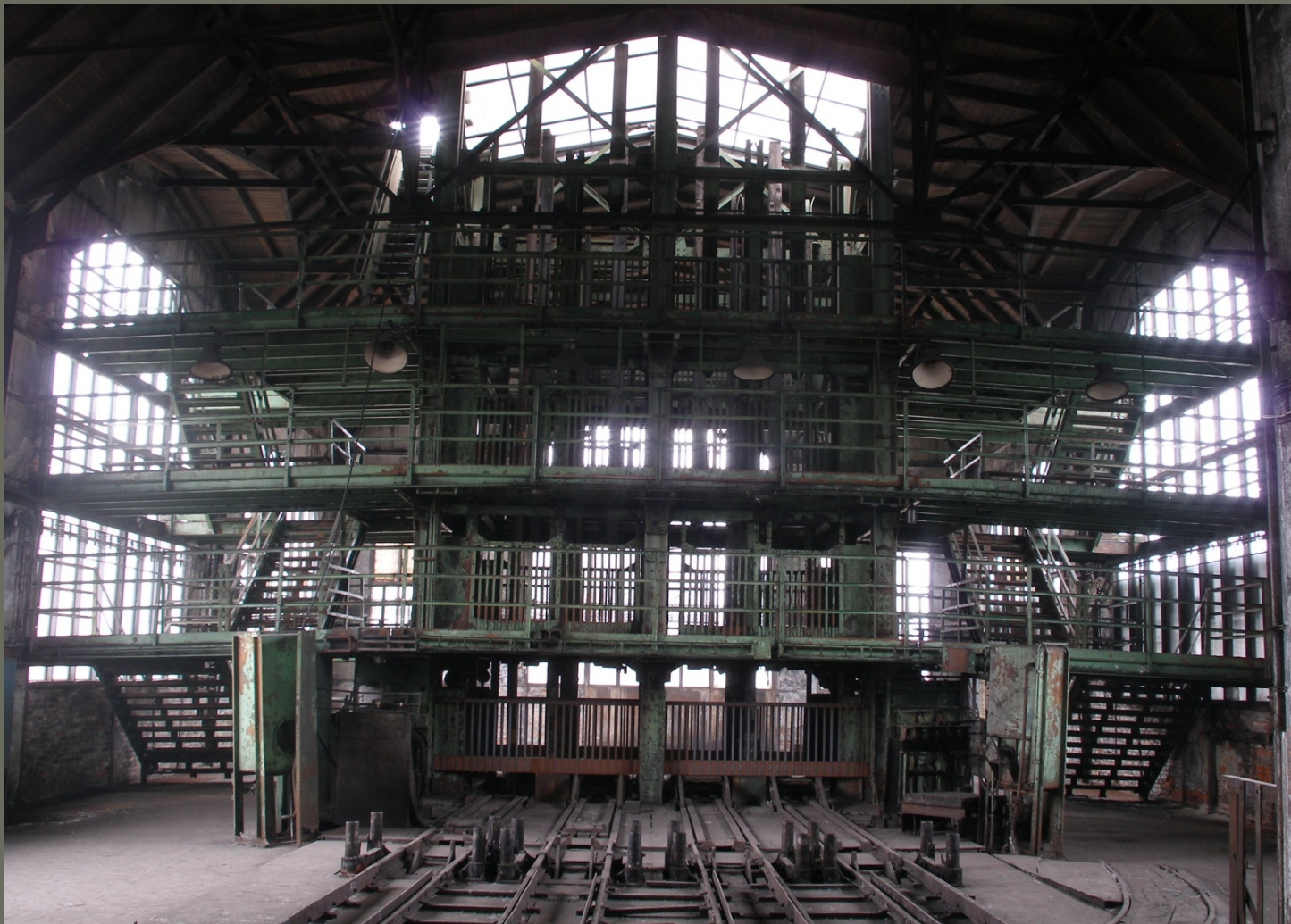
Důl Hlubina, zpřístupněné náraží a oběh vozů v jámové budově
