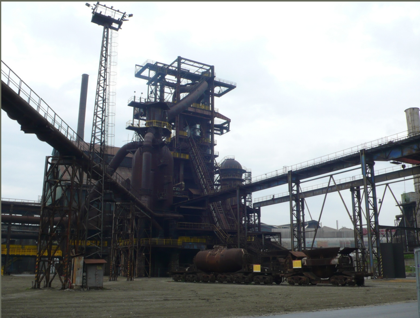
Vysoká pec č. 1, klíčový prvek technologického toku zpřístupněny veřejnosti
